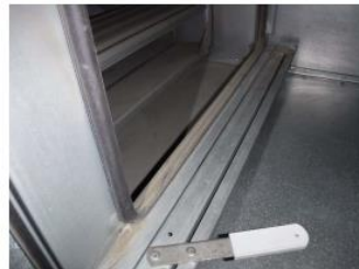
Kuva 6. Tuloilmasuodattimet ei kaikilta osin tiivisty kunnolla koneen runkoa vasten ja ilmanvaihtokoneiden tarkastuksissa havaittiin suodattimen ohivuotoon viittaavia jälkiä (likakertymä).
